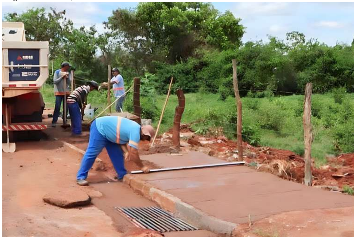
Imagem 123- Construção de bueiro na Avenida de acesso ao Bairro do Carmo.
