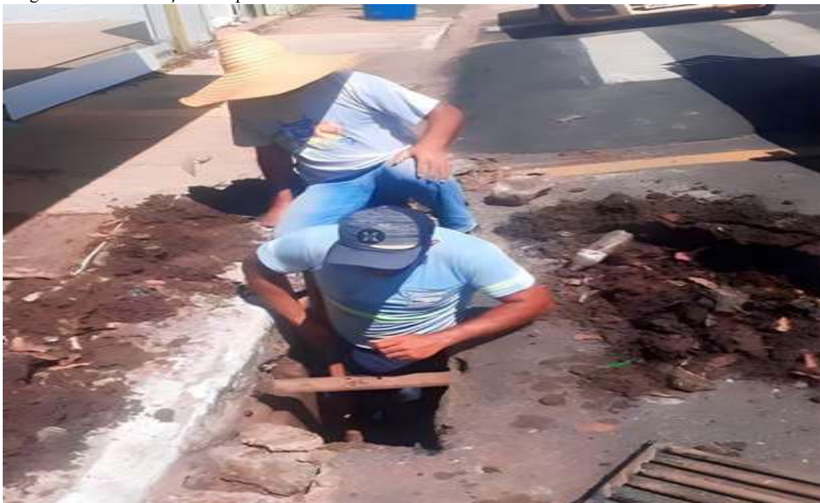
Imagem 129- Manutenção e limpeza de bueiros.
