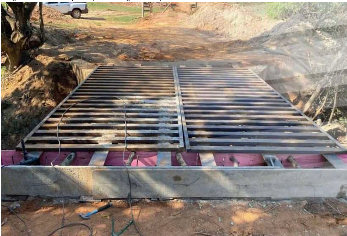
Imagem 126- Restauração da ponte na região Mata preta.
