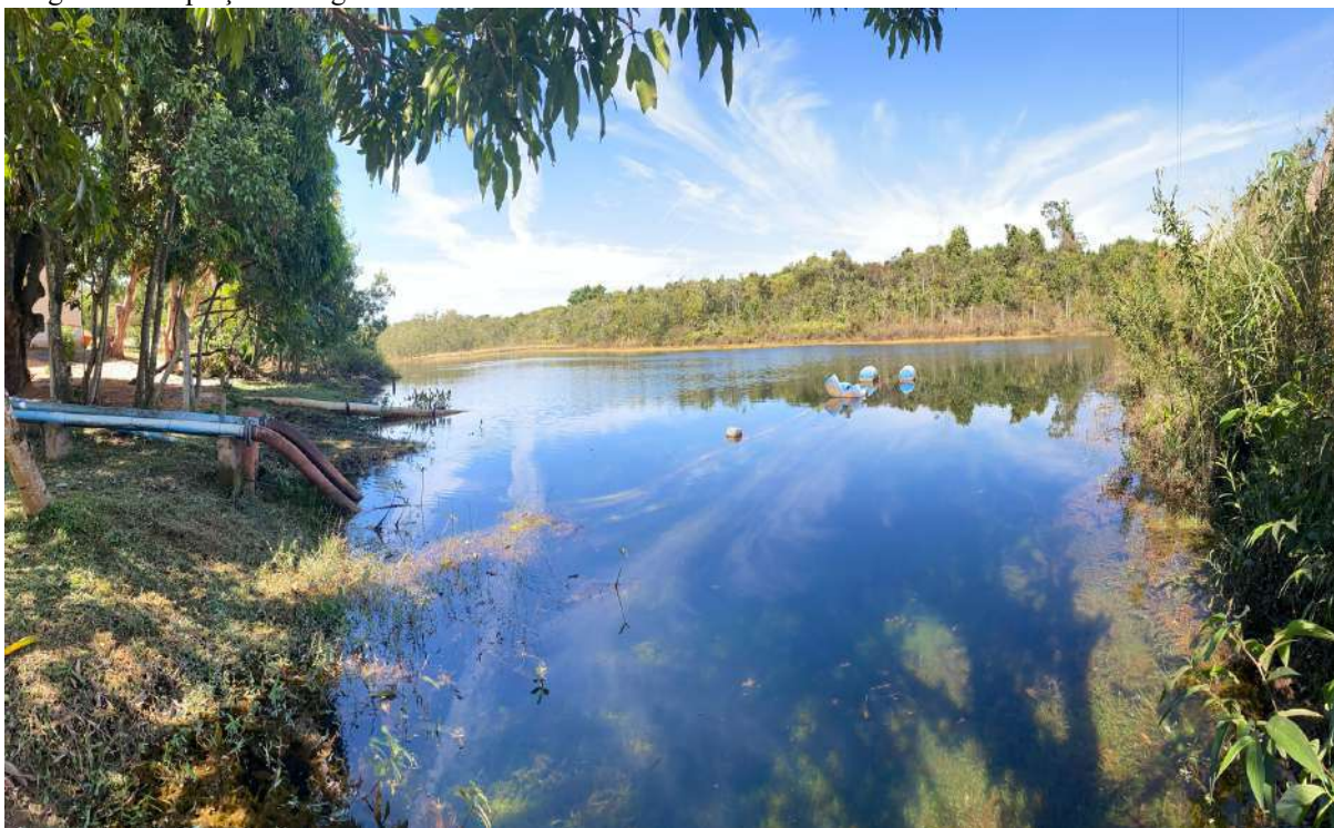
Imagem 42- Captação córrego Santa Bárbara.
