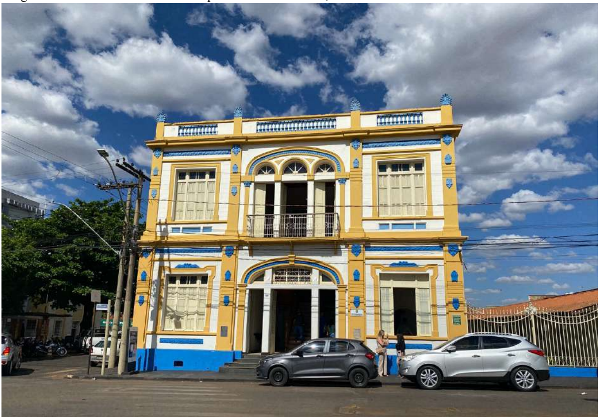
Imagem 7- Prédio da Prefeitura Municipal de Monte Carmelo, MG.
