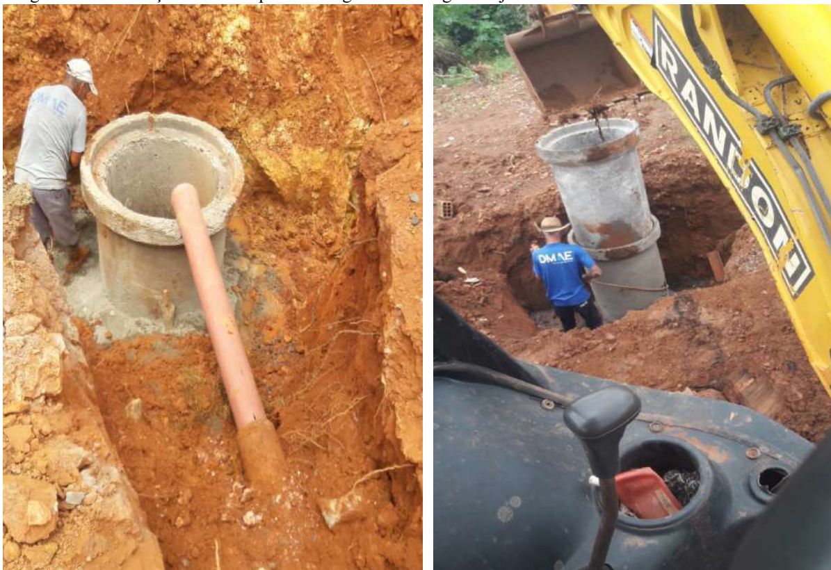
Imagem 64- Construção do interceptor as margens do córrego Monjolo.
