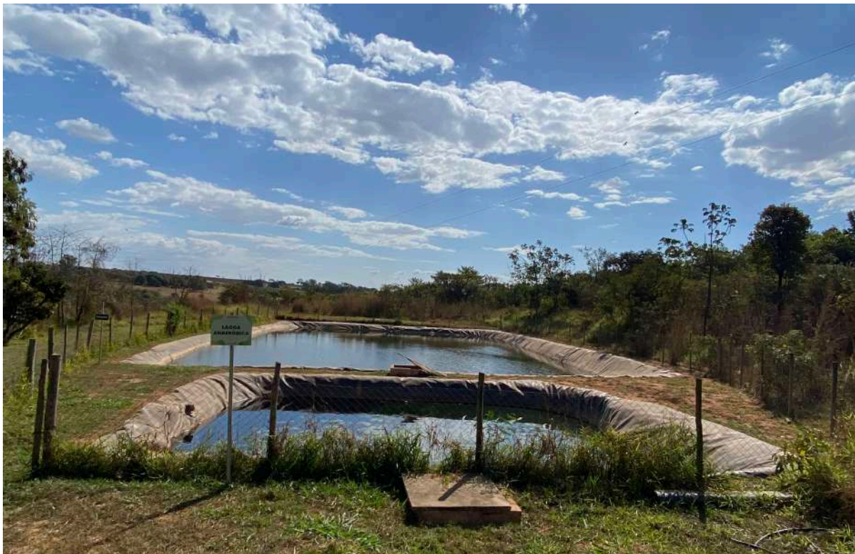
Imagem 86- Série de lagoas anaeróbia e facultativa localizadas no aterro sanitário do município de Monte Carmelo, MG.
