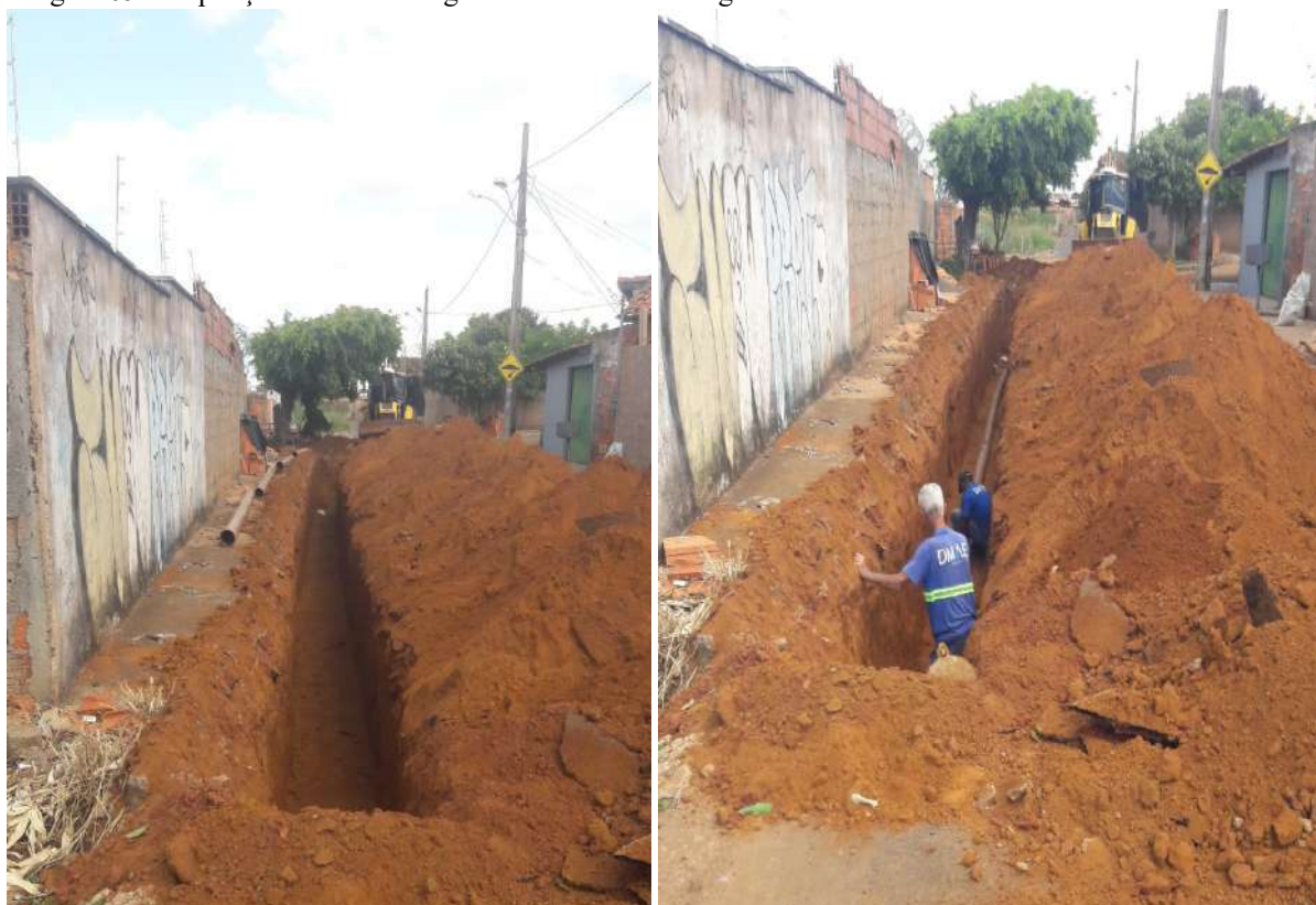
Imagem 65- Ampliação da rede de esgoto no Bairro Santo Agostinho.
