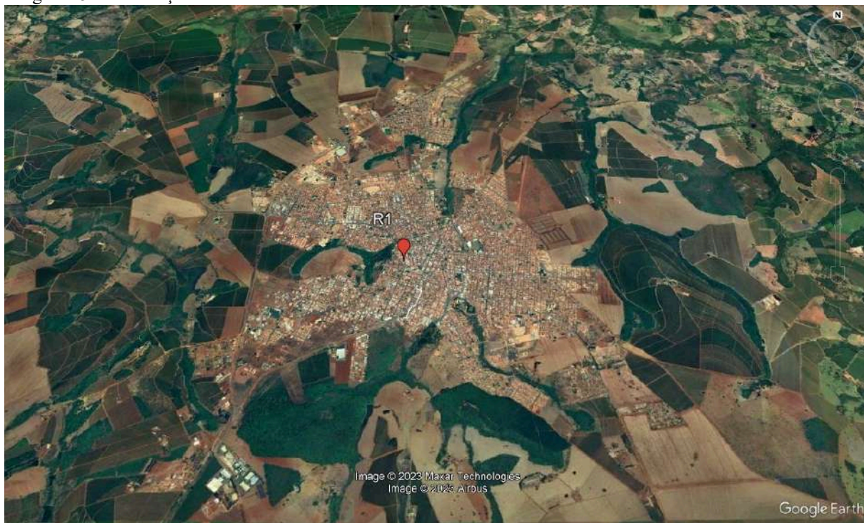
Imagem 45- Localização do reservatório do sistema Santa Bárbara.
