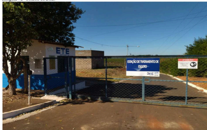
Imagem 72- Guarita da ETE.
