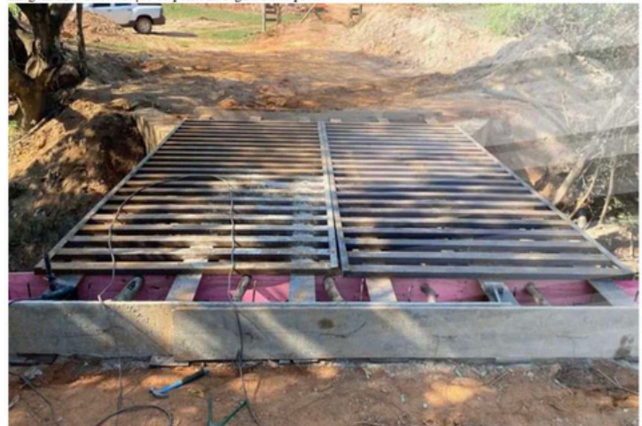
Imagem 126- Restauração da ponte na região Mata preta.
