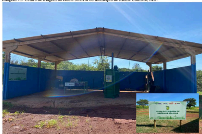
Imagem 91- Centro de triagem da coleta seletiva do município de Monte Carmelo, MG.
