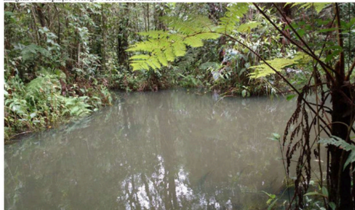
Imagem 50- Captação córrego Vereda da Pindaíba.
