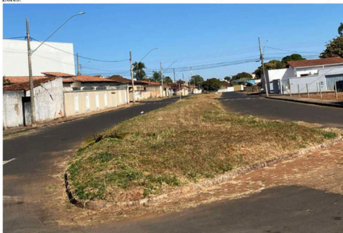
Imagem 119- Trecho canalizado da Rua Perimetral Sul entre a Avenida Braulino Martins Mundim e Rua Waldemar Lores.
