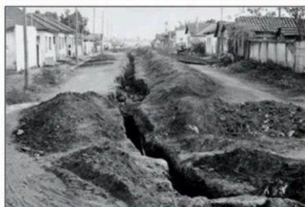
Imagem 31- Início da implantação dos sistemas de saneamento básico no município de Monte Carmelo, MG.
