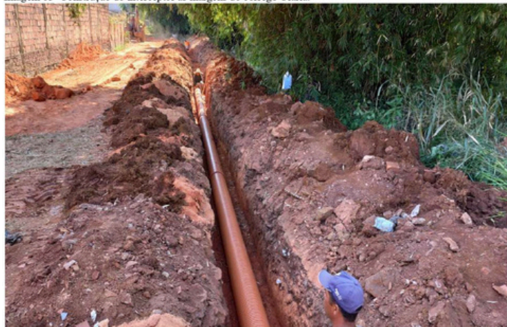
Imagem 63- Construção do interceptor as margens do córrego Olaria.
