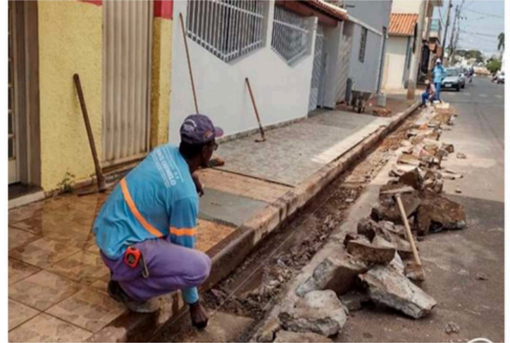
Imagem 124- Manutenção de sarjetas.
