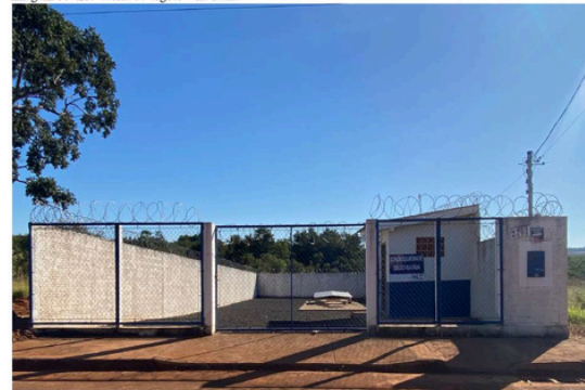
Imagem 66- Elevatória de esgoto Vila Itália.
